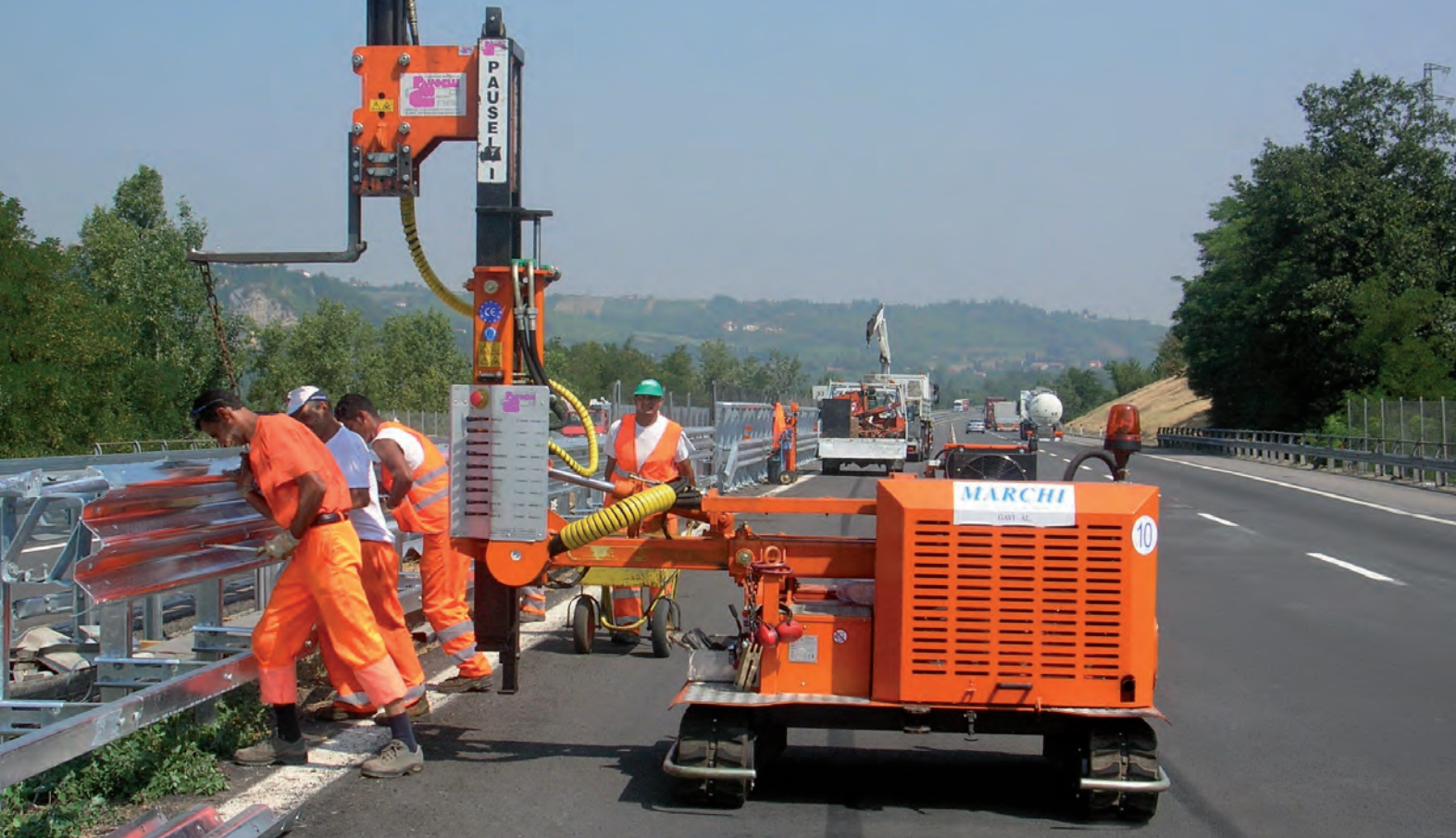
Montaggio di una barriera stradale sullo spartitraffico centrale. Autostrade per l'Italia A26 tratto Ovada - Alessandria. Median safety barrier installation. A26 Highway Ovada - Alessandria section - Italy.
