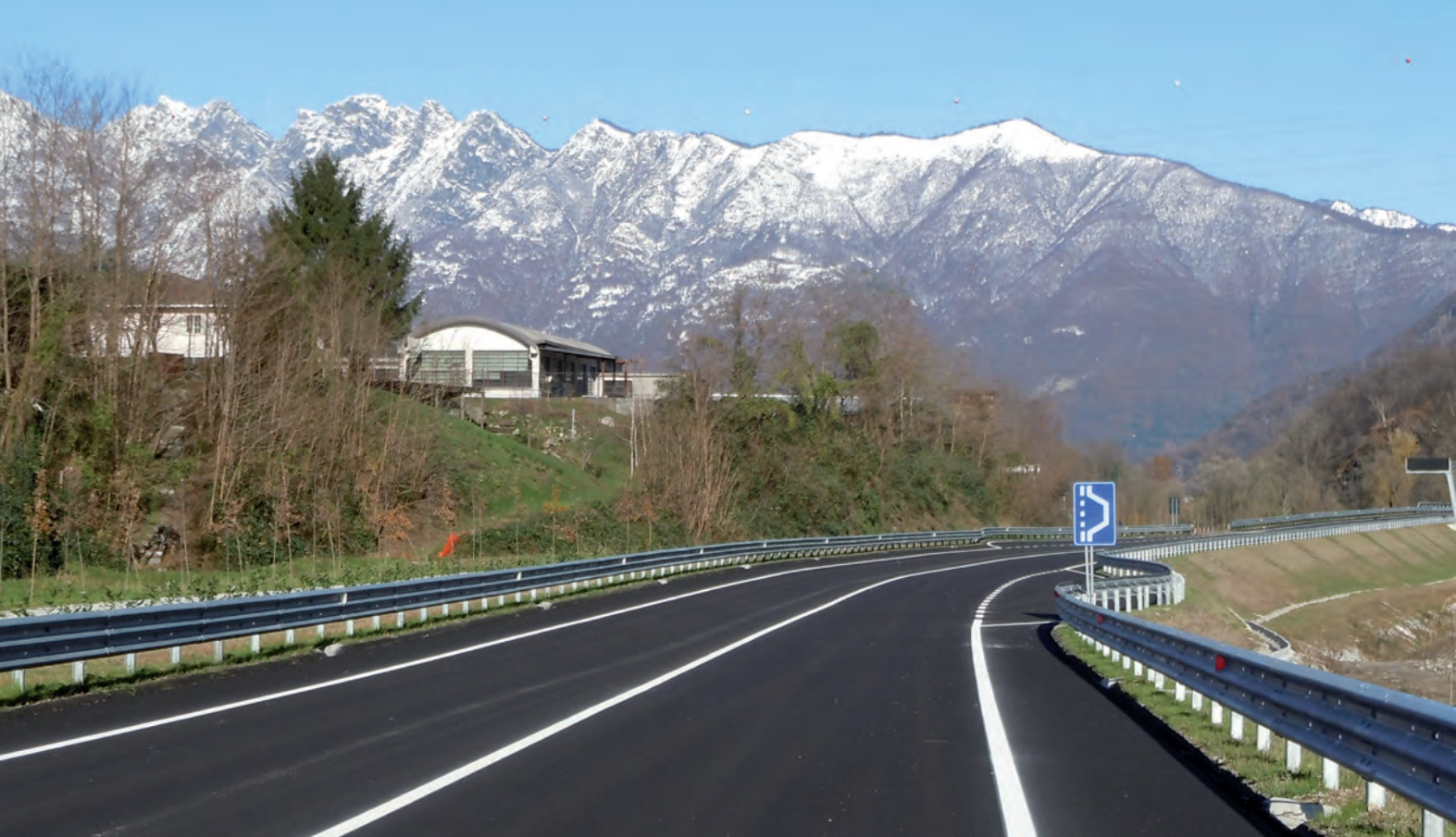
Barriera in classe H2 bordo laterale S.R. n.229 Variante di Omegna - Gravellona Toce (VB) H2 class safety barrier 3 waves - Regional Road n.229 Omegna variant - Gravellona Toce (VB)
