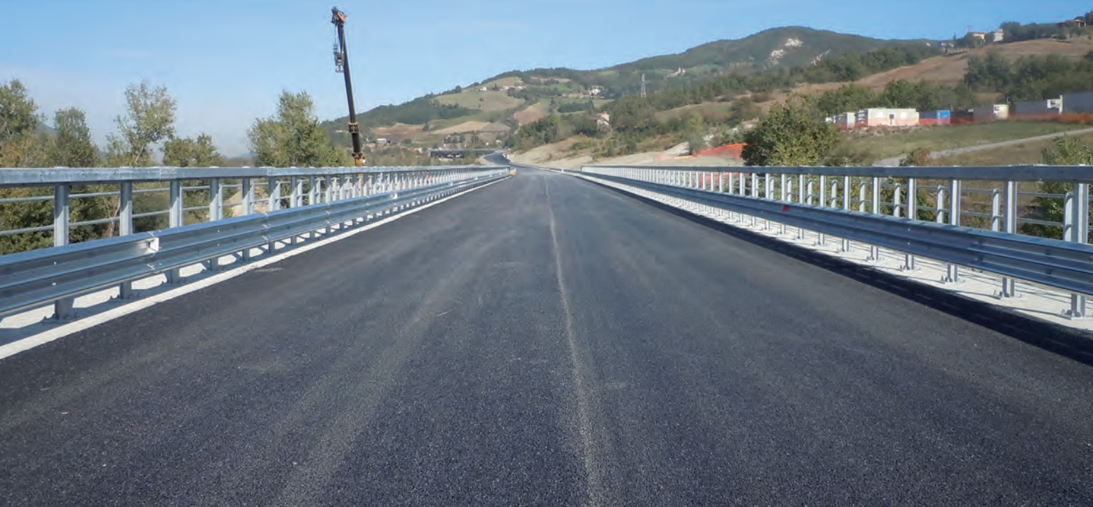
Barriere in classe H3 bordo ponte e parapetto a tre tubi. SS 45 Val Trebbia. H3 class side bridge safety barrier. State Road 45 Val Trebbia - Italy.
