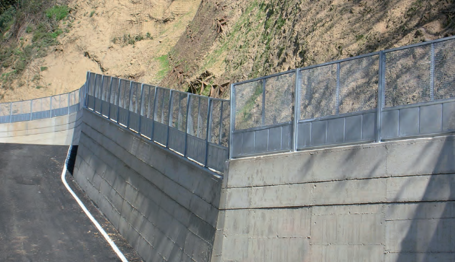
Pannelli in rete e lamiera per uso parasassi di dimensioni 3,00 x 2,00 fissati a un montante IPE 100. Rock falling protection and safety mesh panels.
