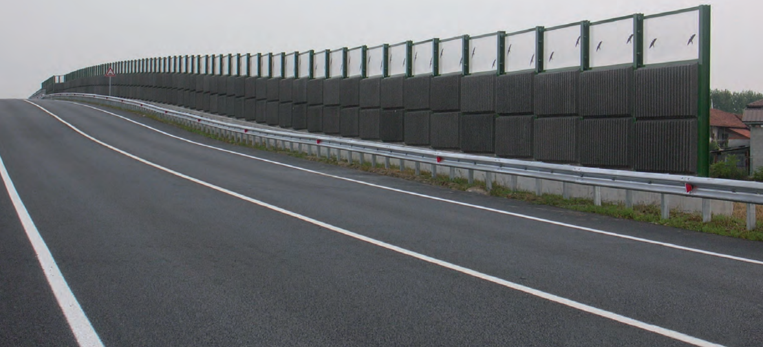
Barriera acustica in Beton bois con pannello trasparente superiore e barriera H1 a protezione. Variante di Racconigi (CN).
