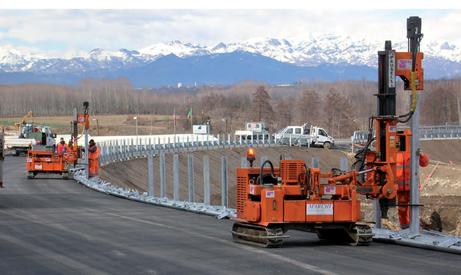
I nostri mezzi durante il montaggio di una barriera stradale. Asti - Cuneo, Sant'Albano Stura (CN) Our machines installing a safety barrier. Asti - Cuneo, Sant'Albano Stura (CN)
